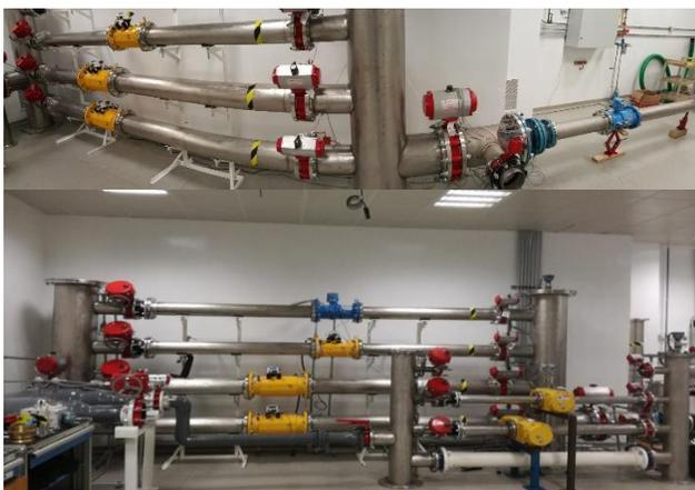
**Figura 6.** Instalación e integración de todos los medidores de referencia.
